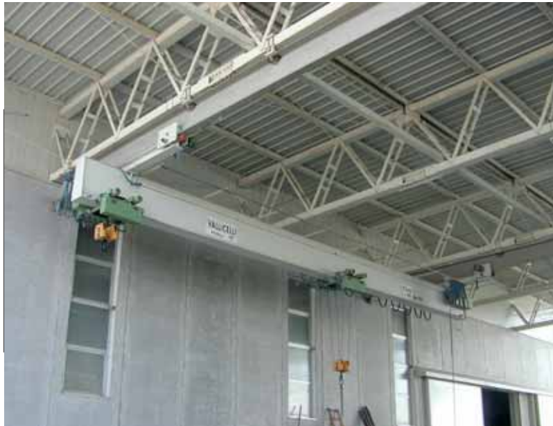
gru a ponte sospeso con trave sfilabile
